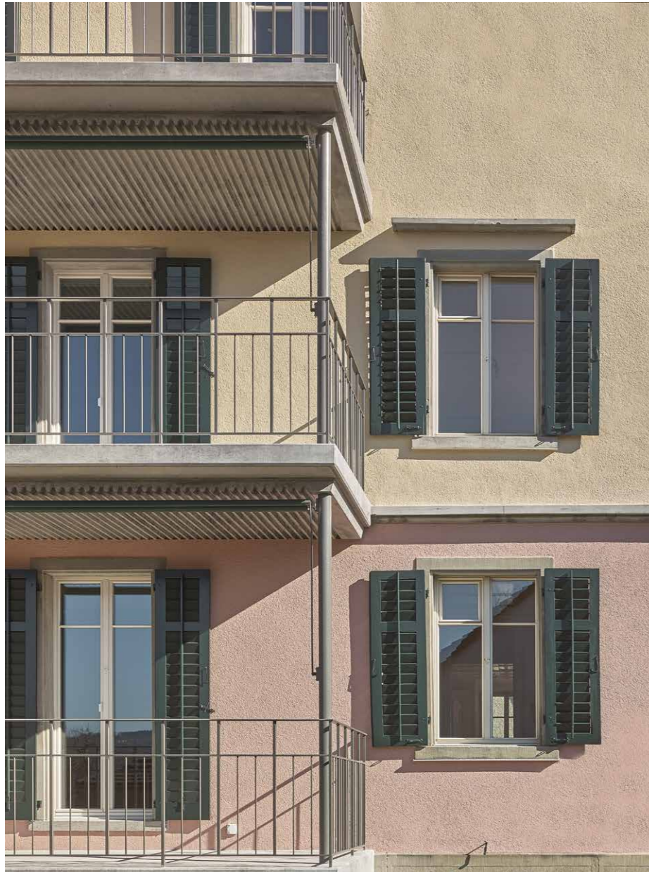
Neubau Balkone, Sanierung Fassade
