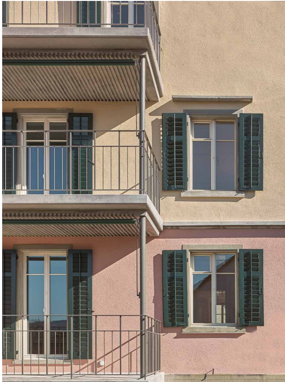
Neubau Balkone, Sanierung Fassade
